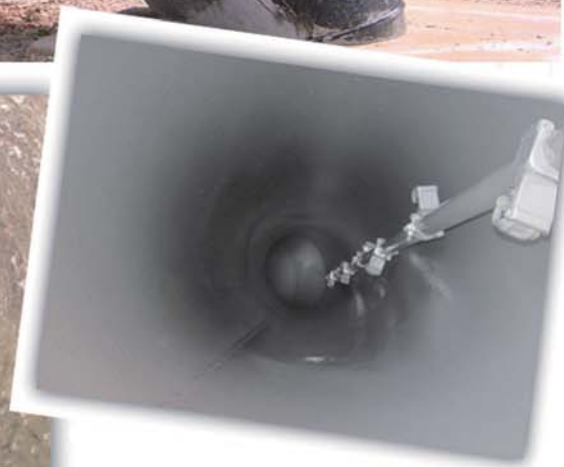
CERACOAT 시공 후
