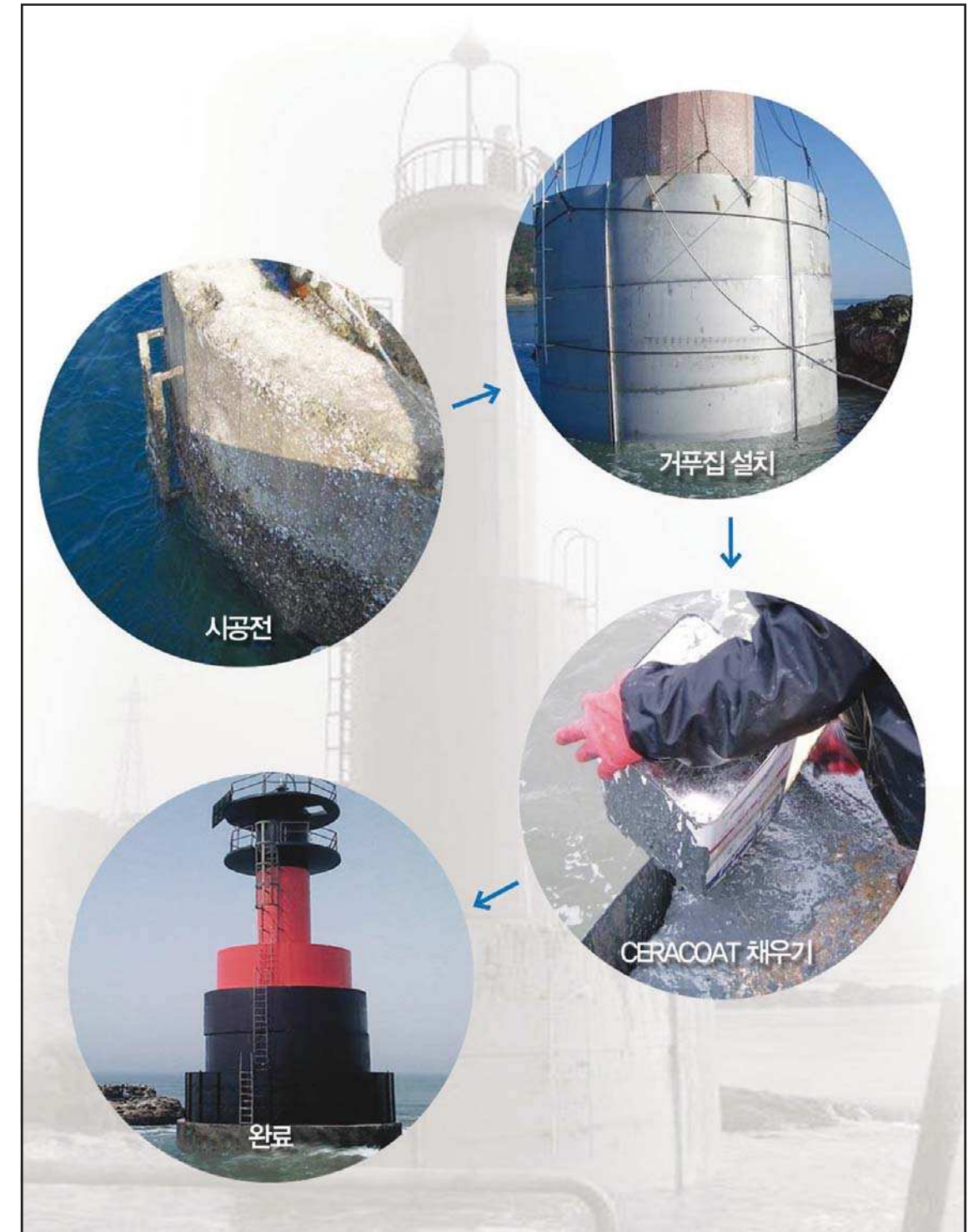
소야리 등대 해중부 보수/보강 공사 (인천 지방 해양수산청 2003)
