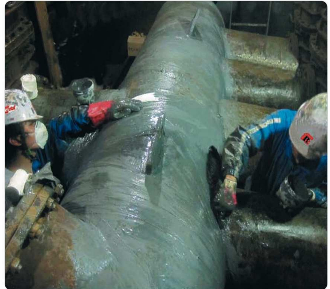
삼성중공업 도크내부 보수
